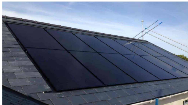
9 Suntech Ultra V mini PV panels
